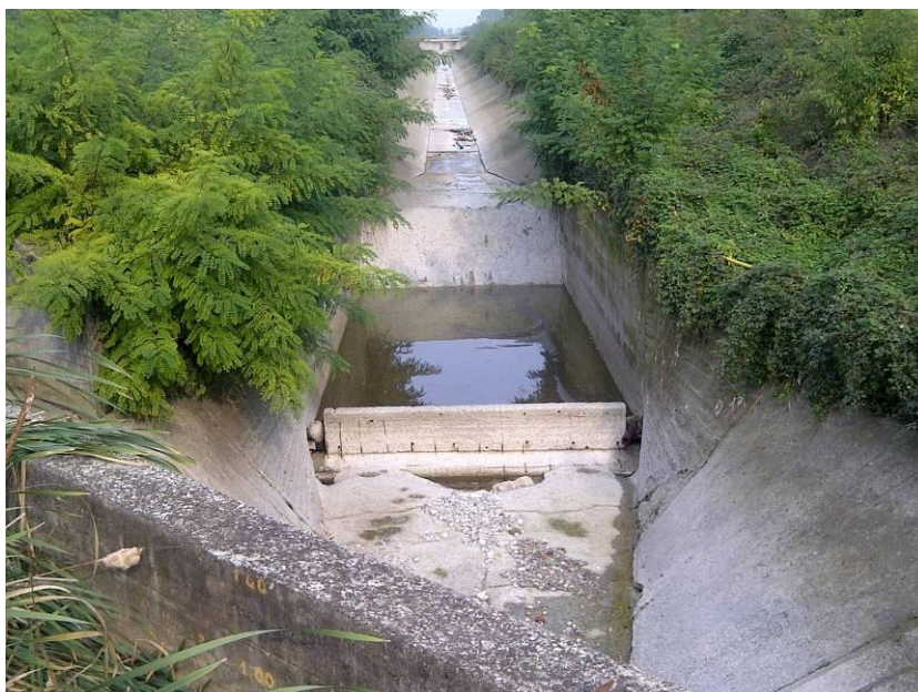
Figura 37 – Vasca di dissipazione esistente a valle del salto ove a monte è prevista la realizzazione dell'opera di presa dal CSNO
